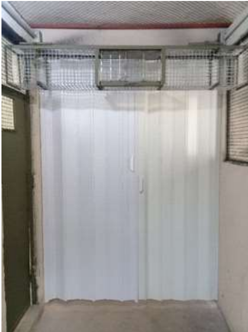
Figura 1 – Túnel de conexão entre recintos.
